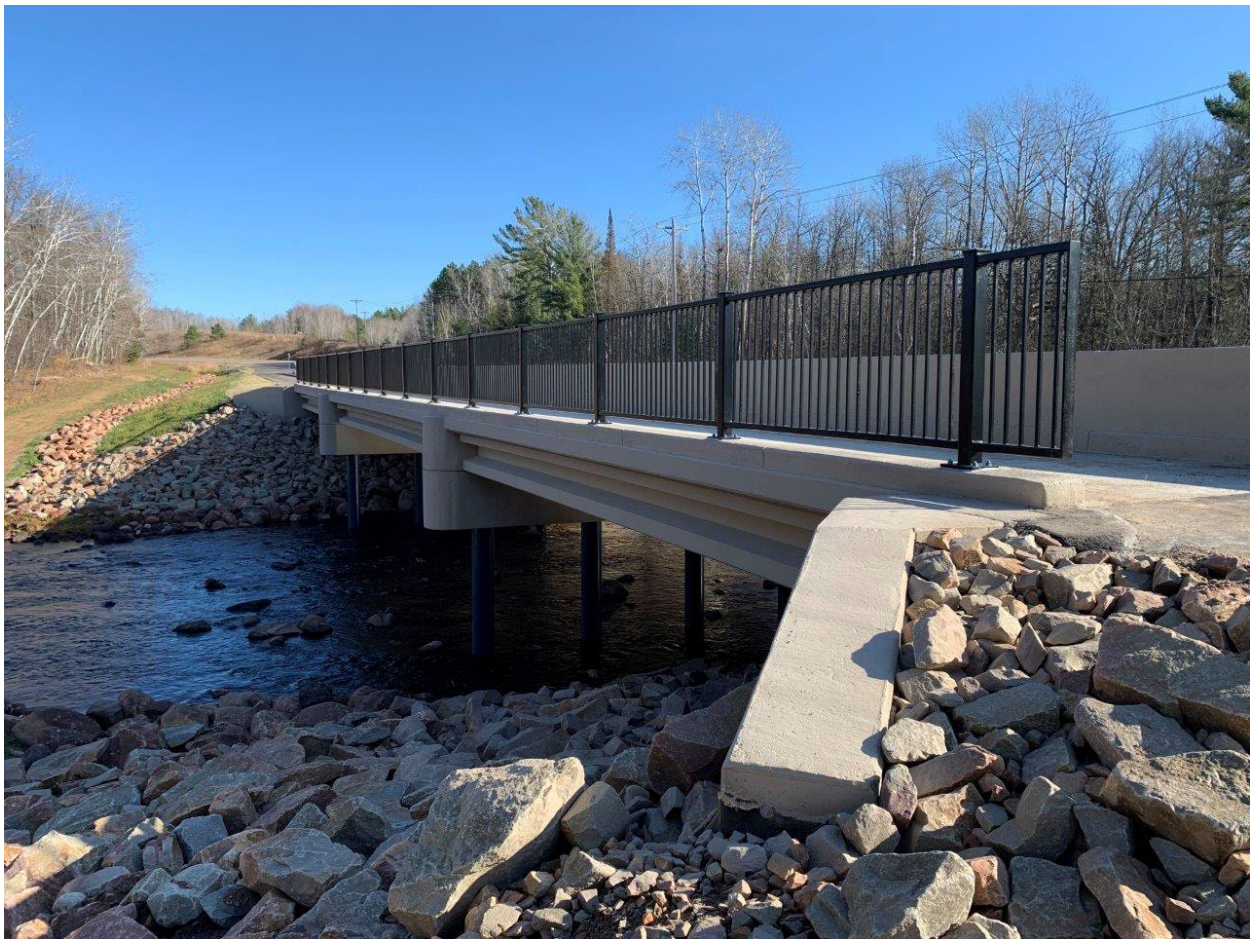
New Bridge 31586 on CSAH 61
